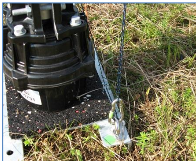
Befestigung „Lift“ Seil an die Rotorplatte
