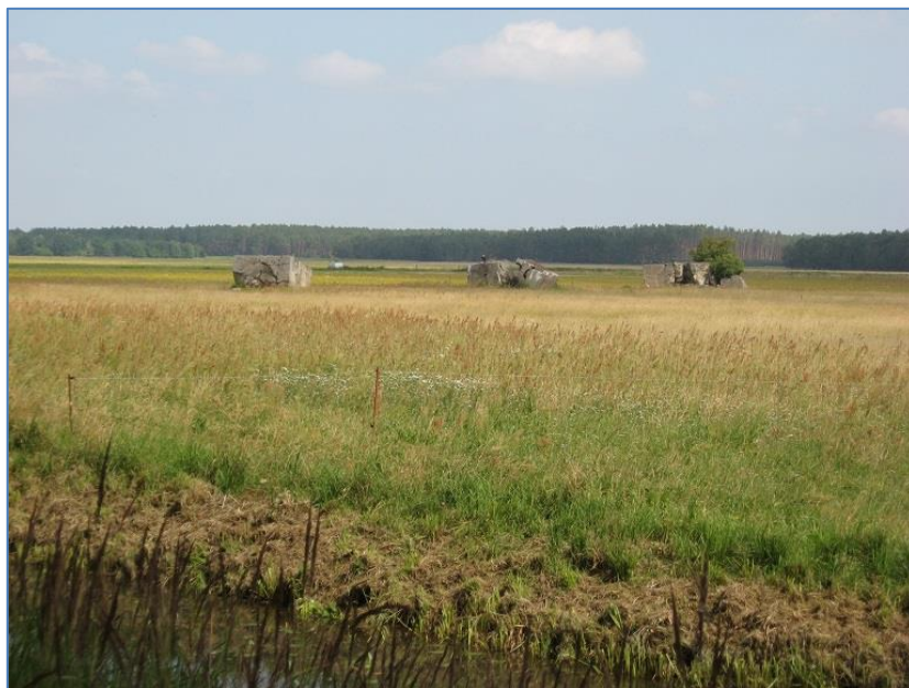
Trümmerreste der Pardunenfundamente
